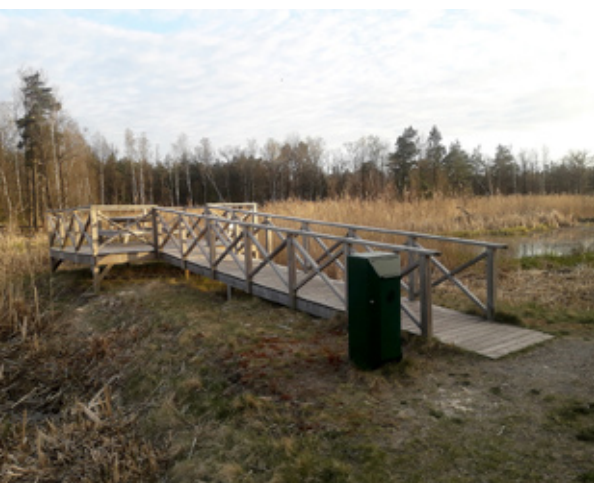
43. Plattform utmed stigen genom våtmarken vid en av de mellersta dammarna. Foto: Jan Gustafsson
