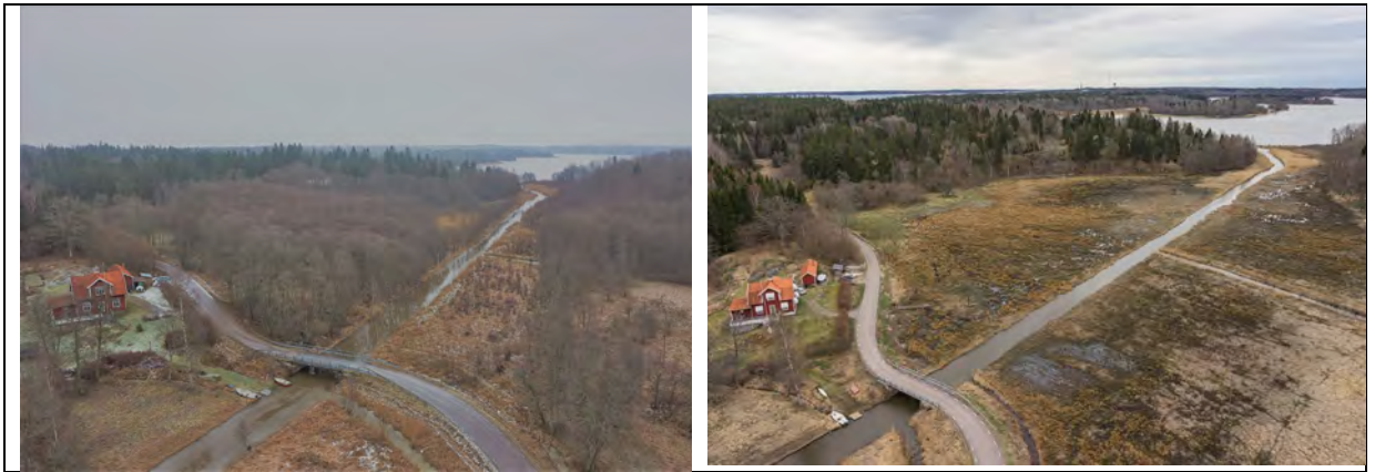
Bilder från Nynäskanalen före och efter åtgärd. Foto Janne Höglund.
