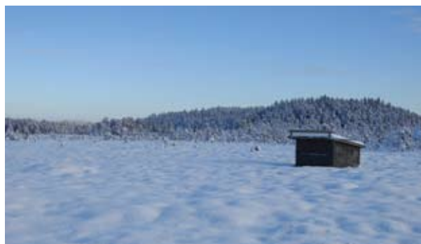
Den nyrenoverade orrkojan på Stora Bötet. Foto: Henrik Andersson.
