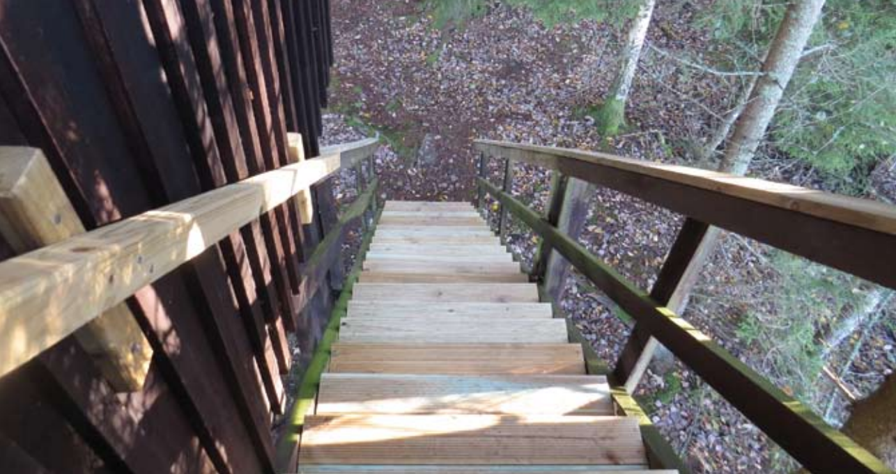
Under hösten 2017 renoverades både trappa och del av golvet till tornet. Foto: Lennart Eriksson
