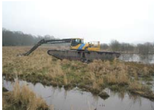
Grävaren börjar sitt arbete i våtmarken under april månad
